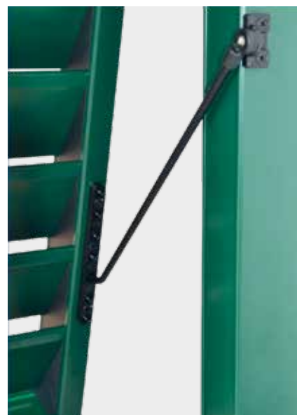
PARTICOLARE BRACCETTO FERMA-SPORTELLO APRIBILE.
